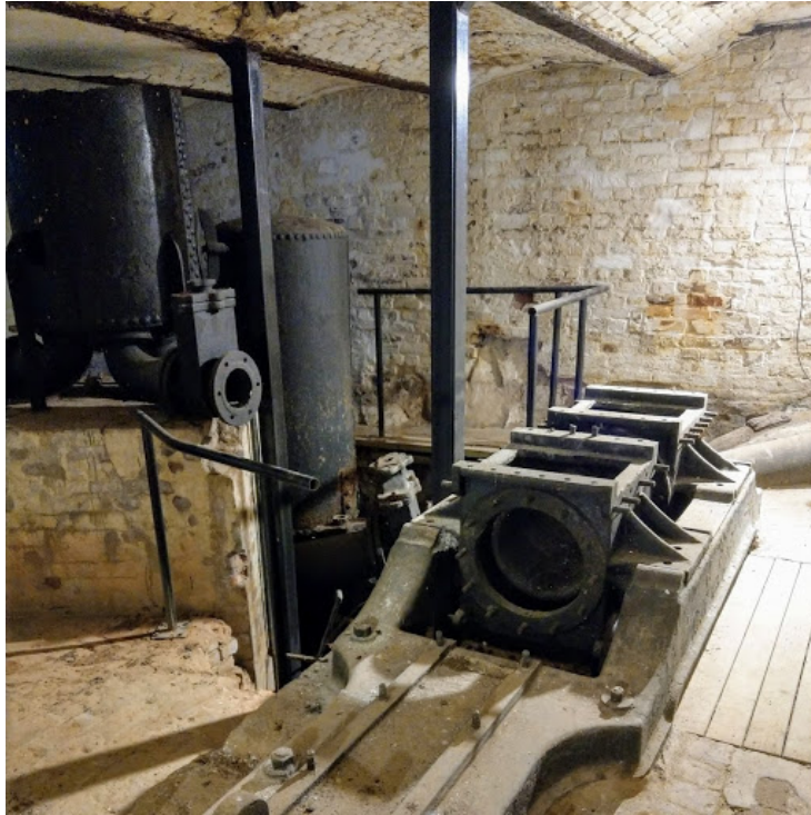
Pumperom med trykktanker før rehabilitering.
