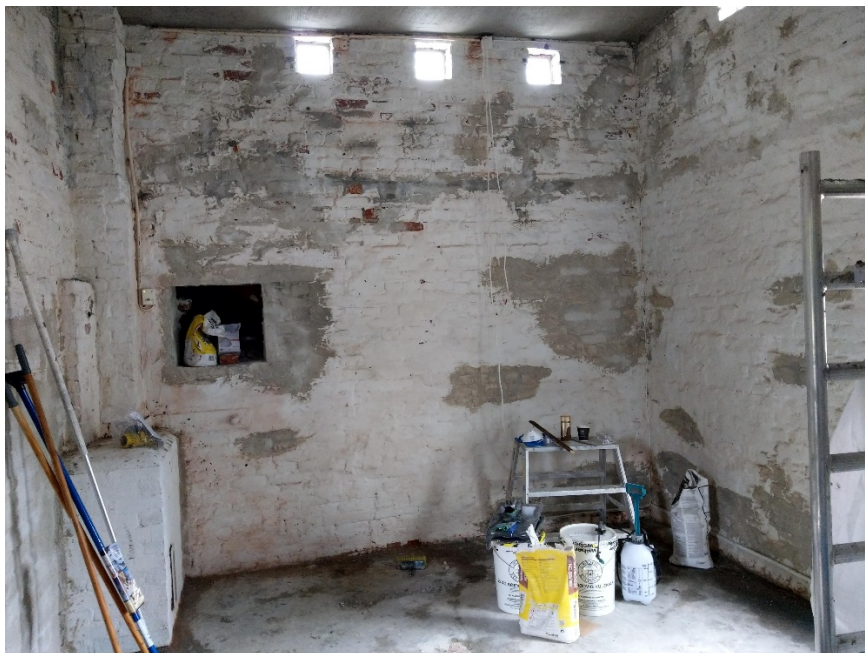
Transformatorrommet før oppussing
