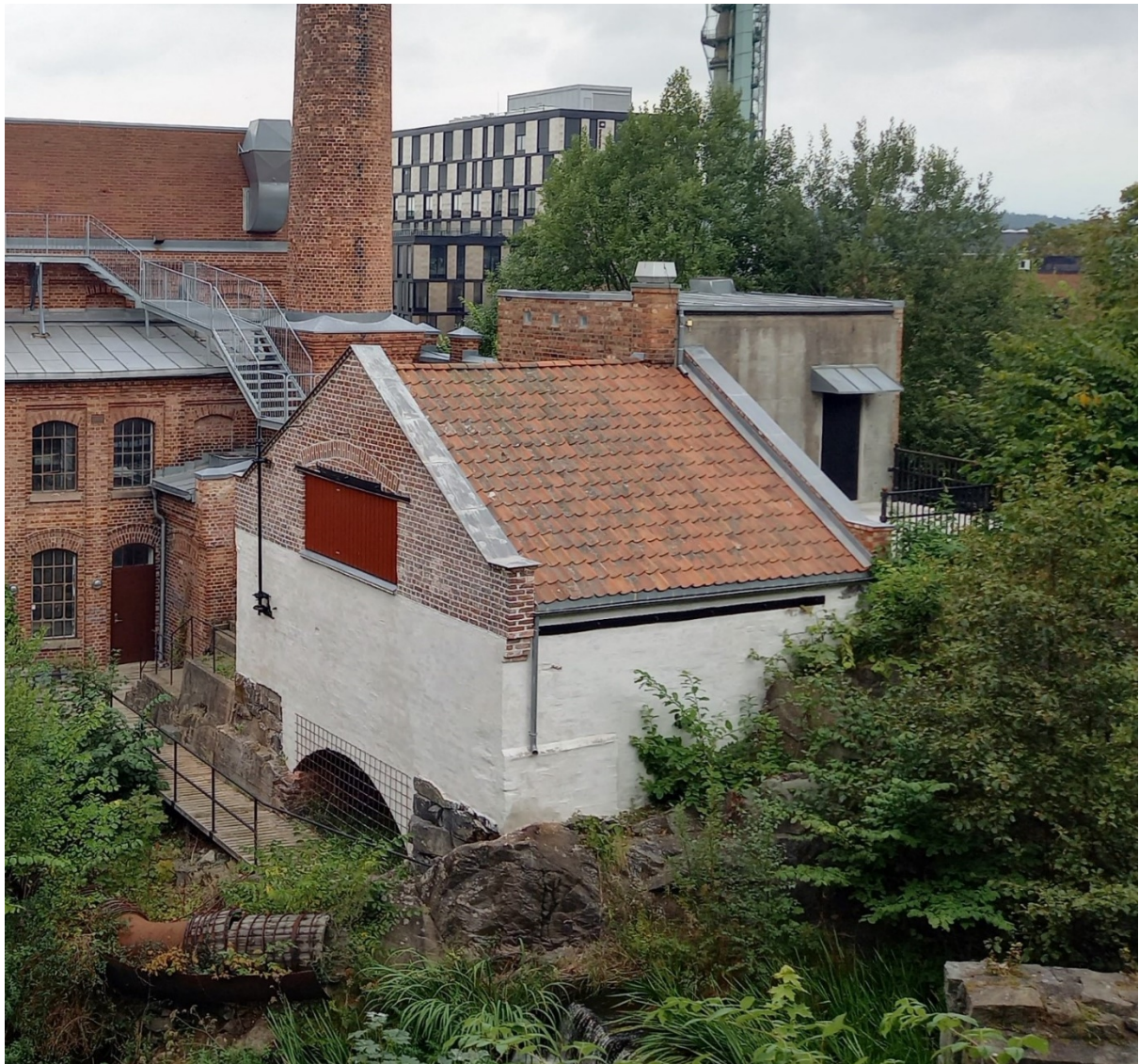
Gamle Moss Vannverk anno 2020
