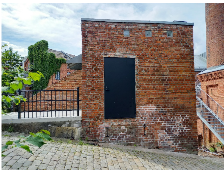
Ferdig restaurert nordvegg
