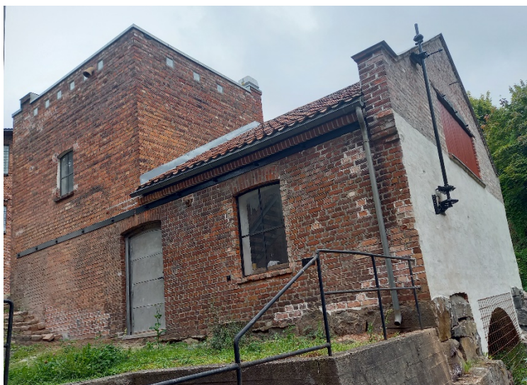
Ferdig restaurert vestvegg
