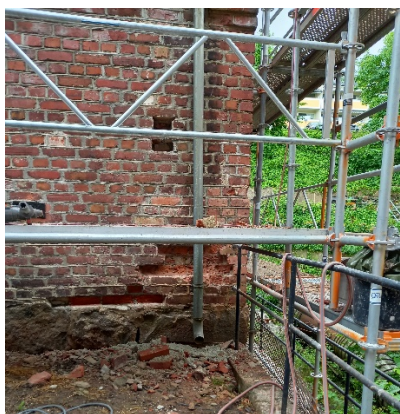
Fasadeskader på vestvegg
